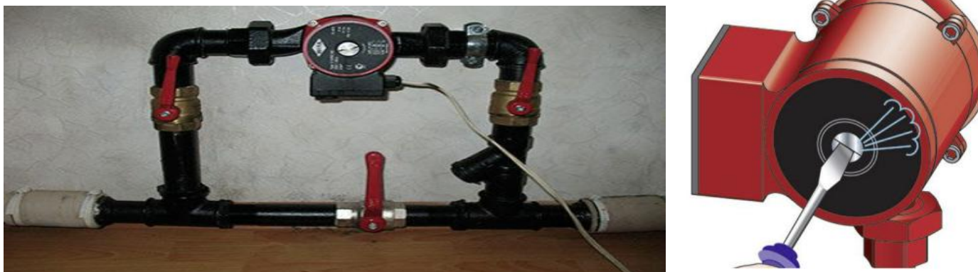
Рисунок 2.9 – Общий вид циркуляционного насоса в байпасной линии отопления
