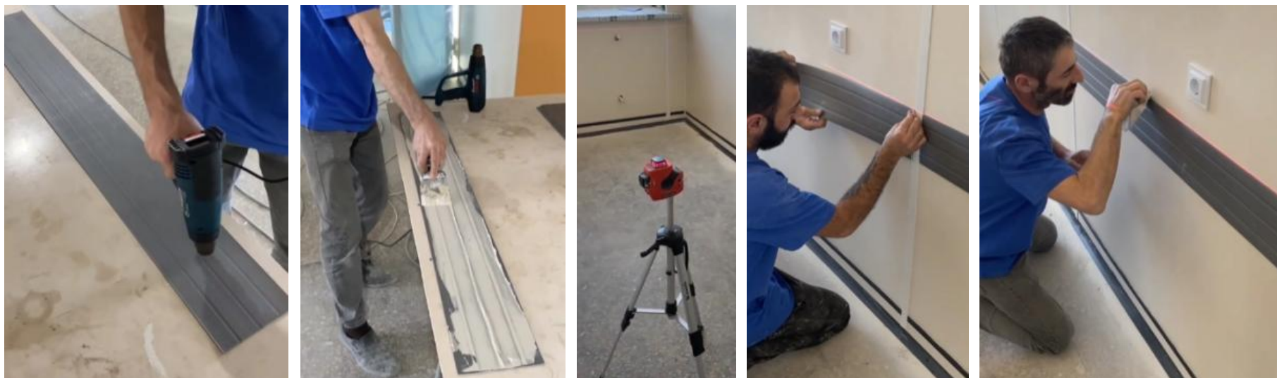
Рисунок 2.4 – Процесс устройства настенной отбойной доски из ПВХ материала
