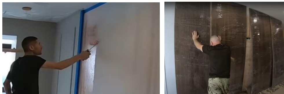
Рисунок 2.1 – Нанесение на основание грунтовочного состава при помощи валика и примерка панелей
