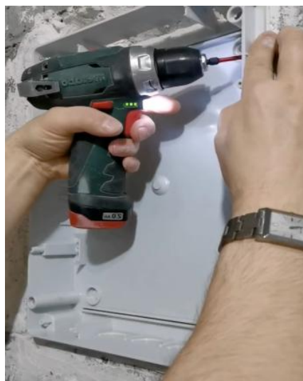
Рисунок 3 – Установка распределительного щитка
