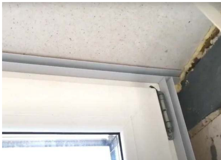
Рисунок 4 – Установка стартового профиля
