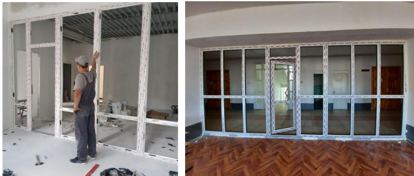
Рисунок 4- Установка ПВХ перегородок
