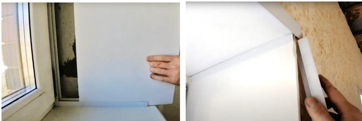
Рисунок 5 – Устройство откоса ПВХ панелями
